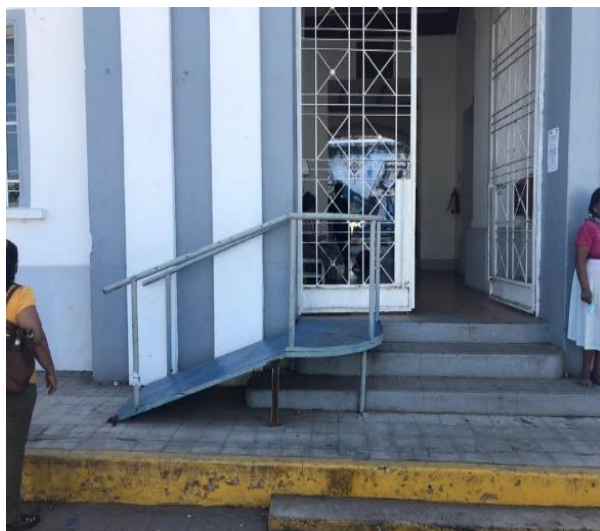
Figura 1. Entrada a la presidencia municipal en Ruiz Nayarit vista frontal. Fuente: Construcción propia.
